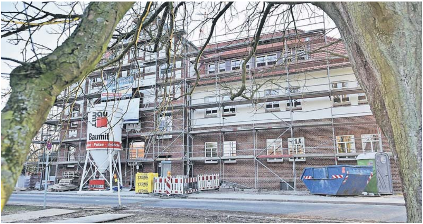
Sanierung und Umbau der Hausnummer 67 im Campus Fichtenhain werden voraussichtlich im Frühjahr fertig sein.
